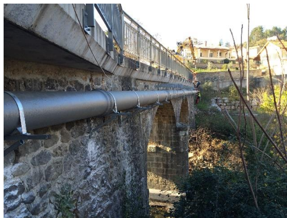
FIGURE 6 : EXEMPLE D'ENCORBELLEMENT (SOURCE : RAMPA-TP.COM)
