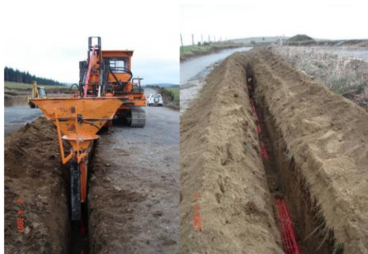
FIGURE 3 : REALISATION DE LA TRANCHEE ET POSE DES CABLES
